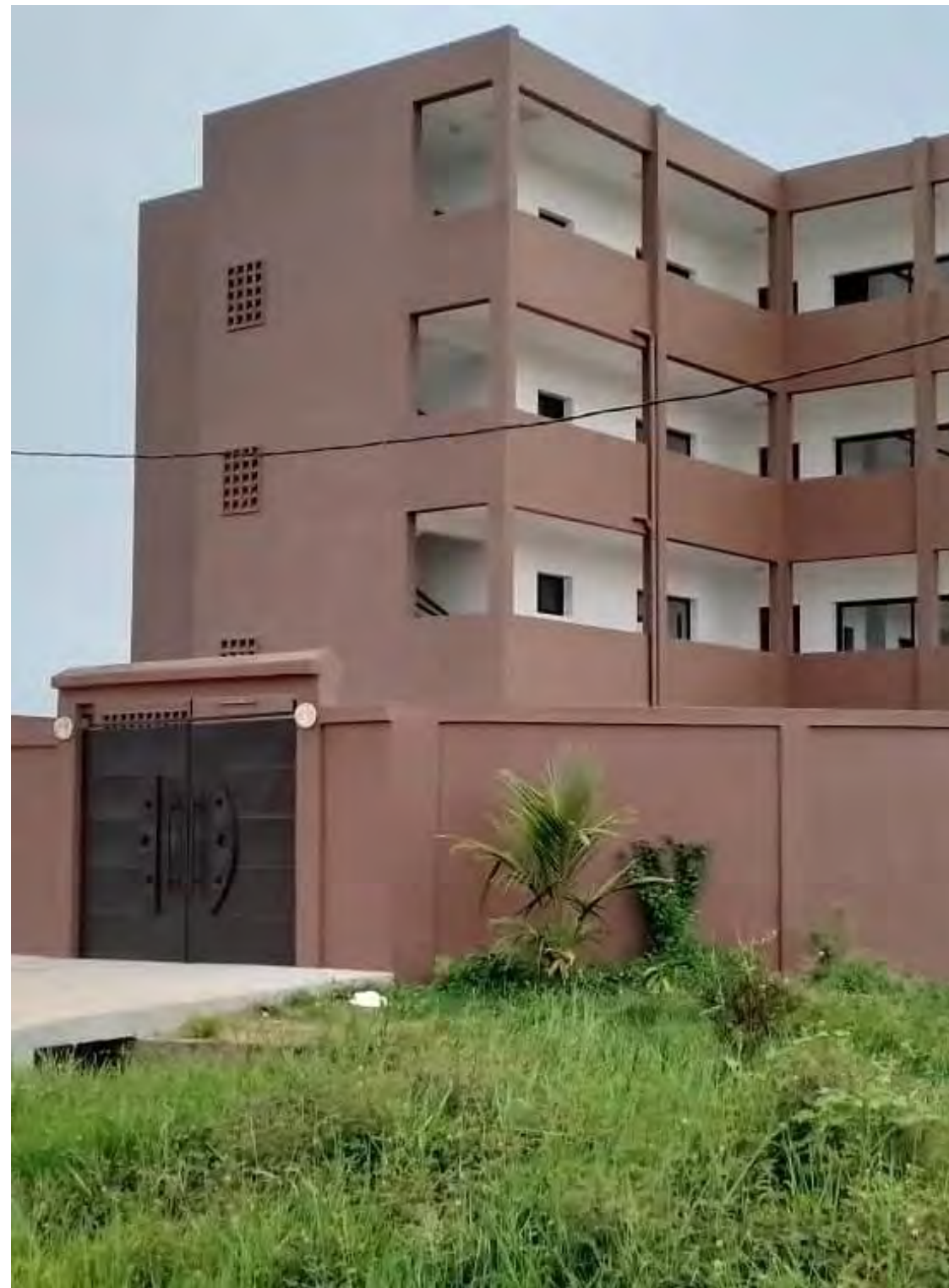
■ Immeuble R+3 — Grand-Bassam
